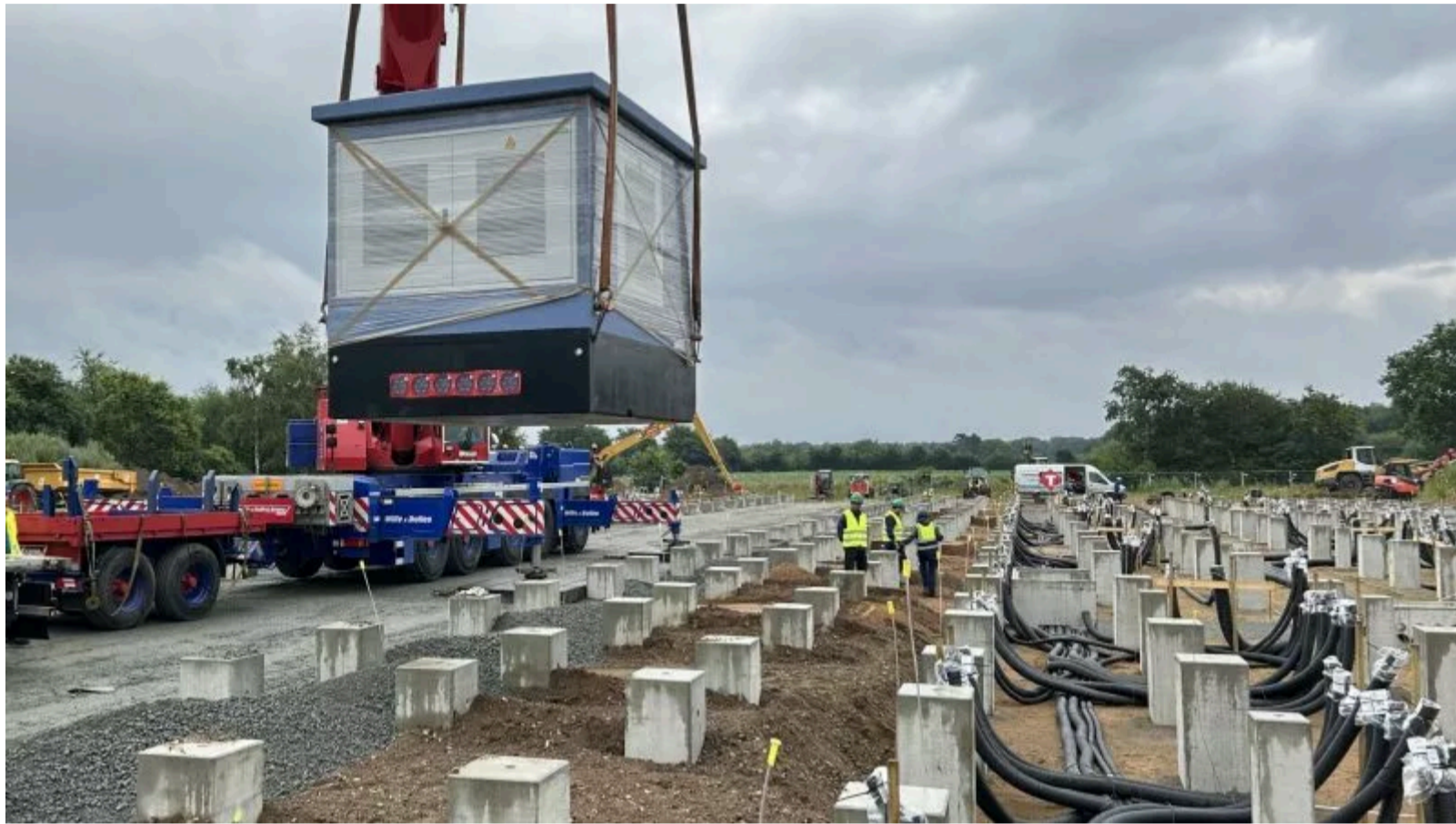
Der Batteriepark Bollingstedt ist im Bau.
