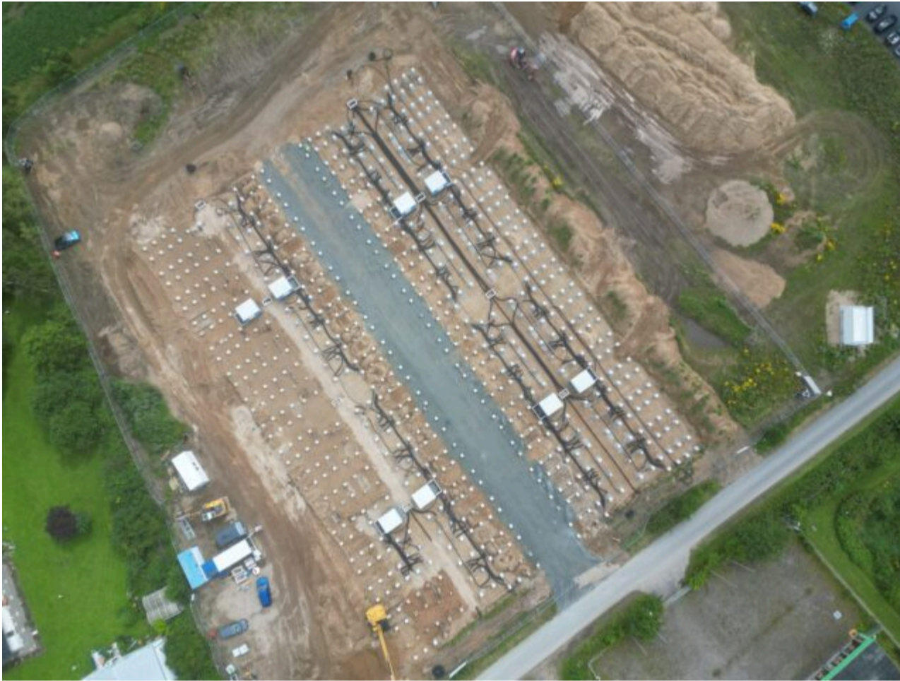
Die Baustelle in Bollingstedt von oben betrachtet. Foto: ECO STOR
